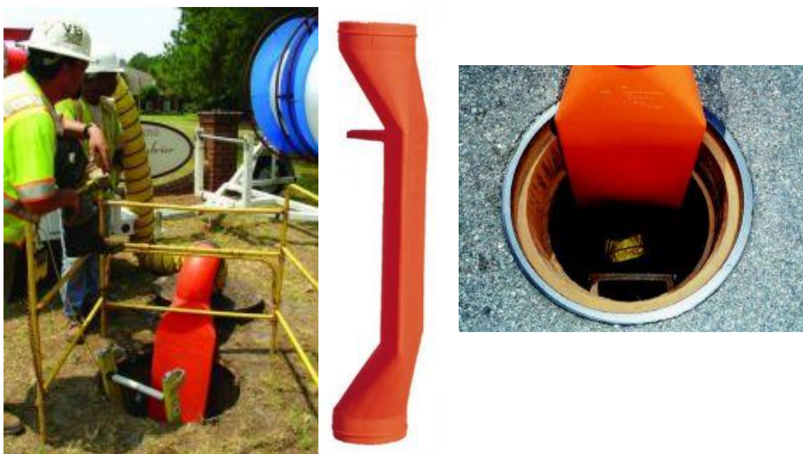
Fig. 25. Accessori per la ventilazione di pozzetti in materiale sintetico. Sono disponibili in materiale semiconduttore per evitare "problemi" elettrostatici . PRODUTTORE airsystems http://www.airsystems.com/
