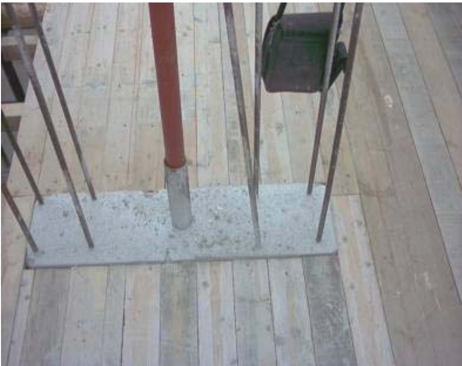
Figura 22. Alloggiamento per il montante di una lifeline ricavato sul getto del pilastro 55 .
