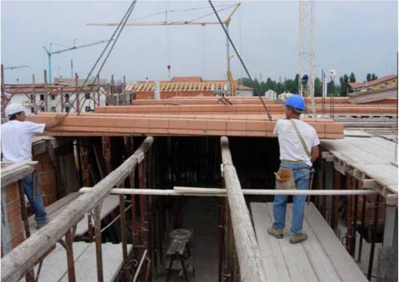
Figura 15. Posa di pannelli utilizzando ponti su cavalletti 42 .
