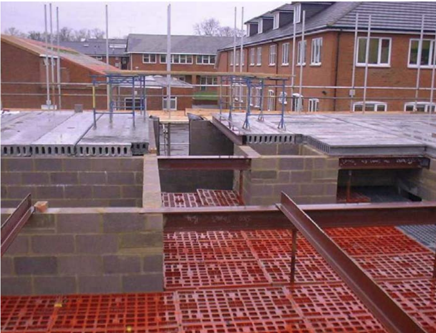
Figura 38. Impalcato di protezione.
