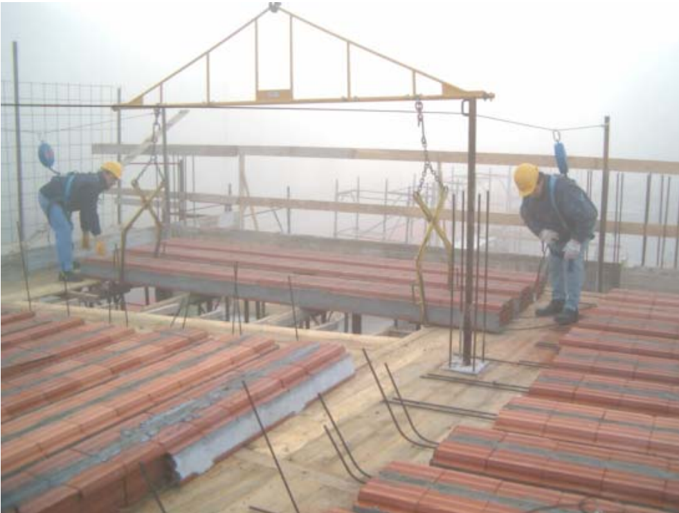
Figura 23. Posa con DPI anticaduta 56 .
