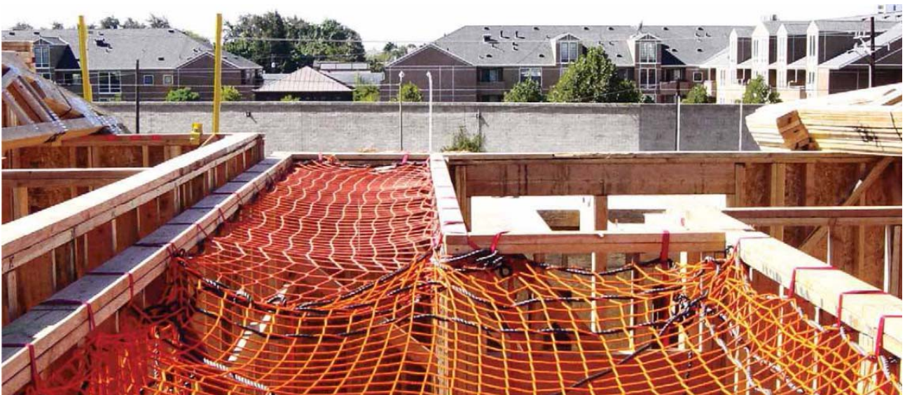
Figura 31. Impiego delle reti di sicurezza 65
