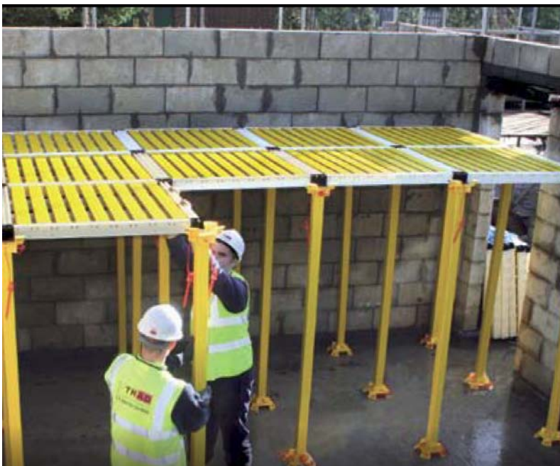
Figura 37. Operazioni di montaggio (TRAD Safety Deck)
