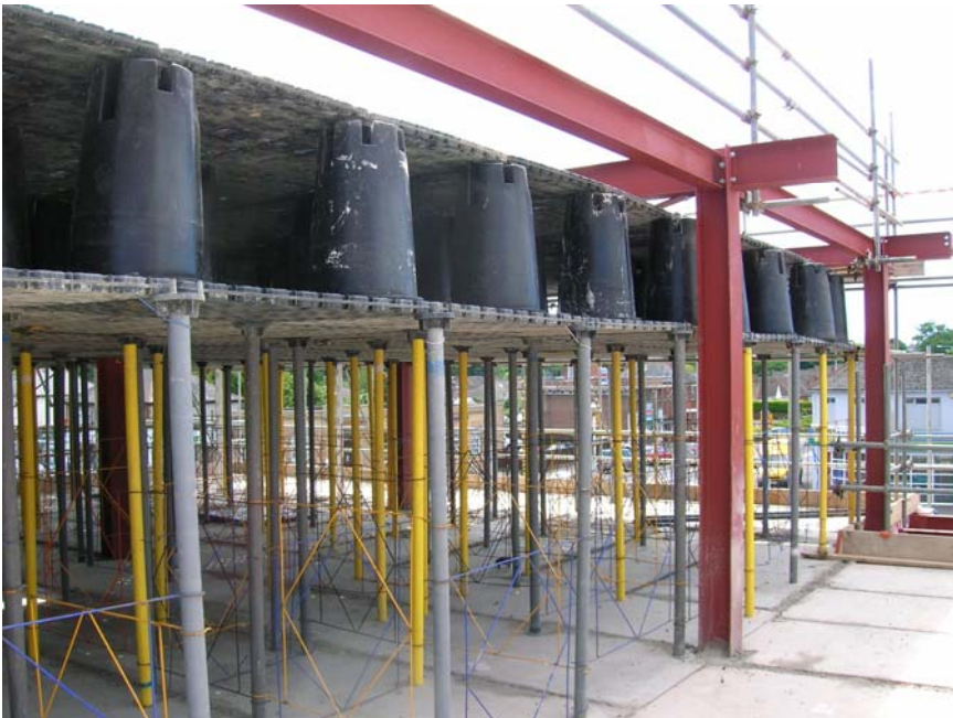
Figura 41. Puntelli di sostegno.
