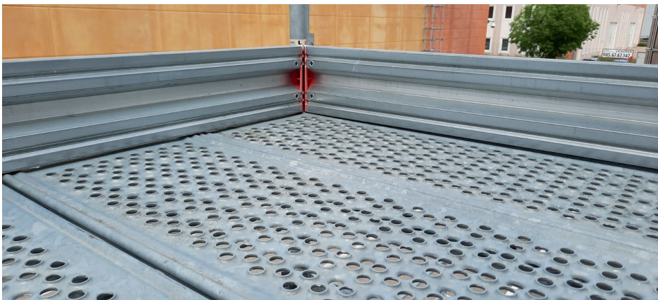
Figura 5.8-3: Fermapiede – Particolare soluzione d'angolo (Fonte: Lahyer)
