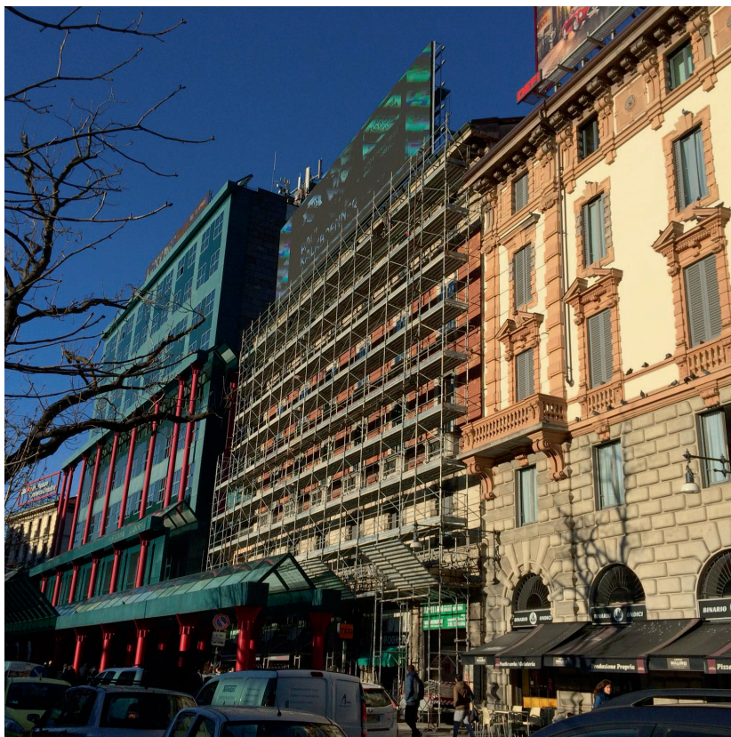
Figura 4.1.1-2: Ponteggio di facciata (Fonte: Eurotempo)
