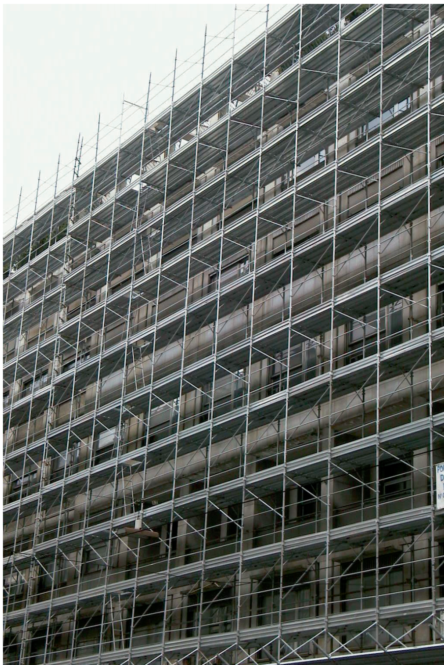
Figura 1.1: Ponteggio di facciata (Fonte: Eurotempo)
