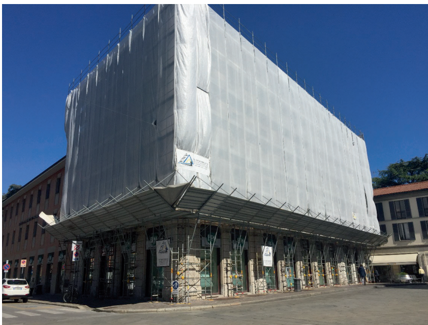
Figura 5.9-1: Ponteggio rivestito con teli (Fonte: Eurotempo)
