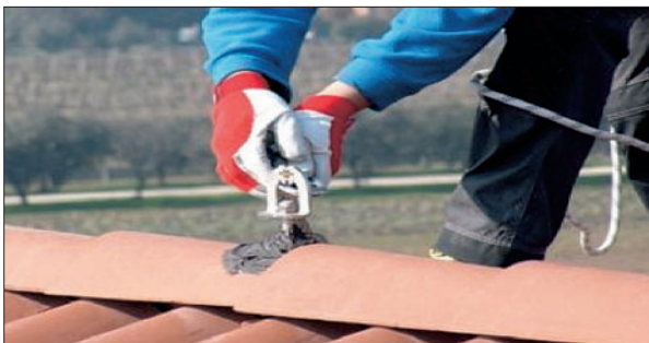
Figura 2 - Tecnico predispone il sistema ad una ispezione straordinaria.
