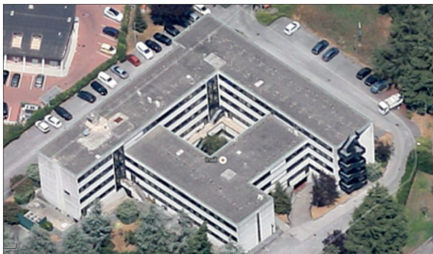
Sede Inail di Lucca foto aerea, stato di fatto.
