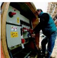
Realizzare impianti elettrici a perfetta regola d'arte, con idonea messa a terra di impianti e masse metalliche al fine di evitare la formazione di cariche elettrostatiche.
