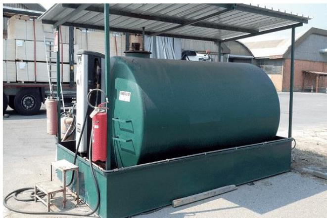
Spesso all'interno di cantieri stradali ed edili dove operano mezzi movimento terra, vengono utilizzati serbatoi-distributori mobili di gasolio aventi specifiche caratteristiche costruttive, con bacino di contenimento alla base e tettoia di protezione dagli agenti atmosferici.
