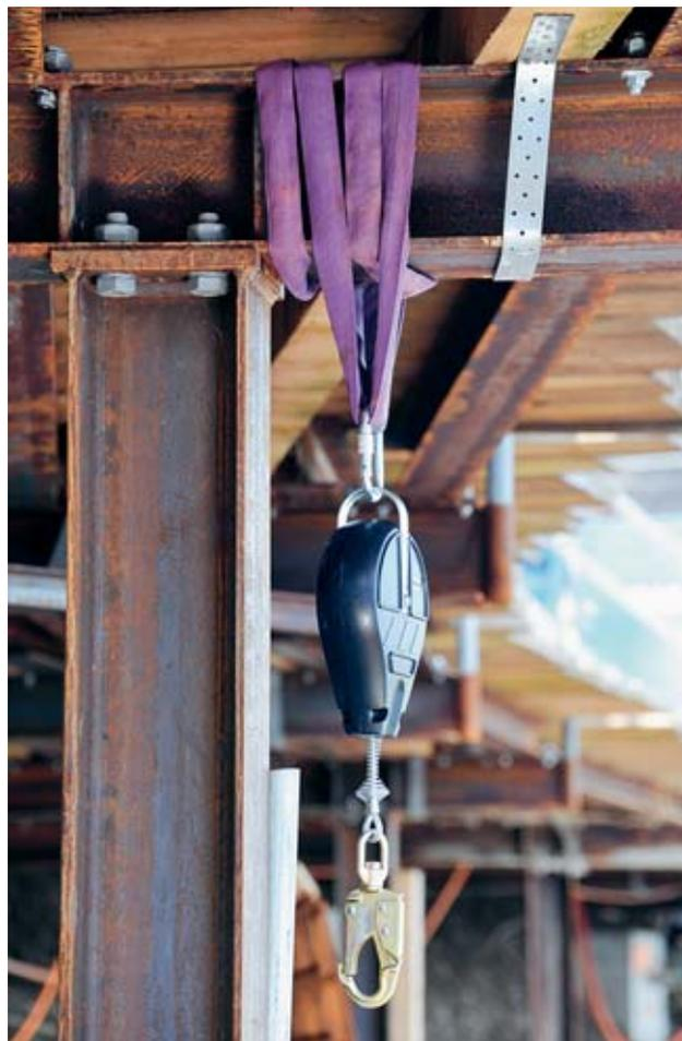
**Figura 23** Fissaggio della fune di sicurezza all'elemento portante di una struttura.
