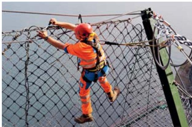
**Figura 8** Messa in sicurezza con imbracatura anticaduta e fune di posizionamento.
