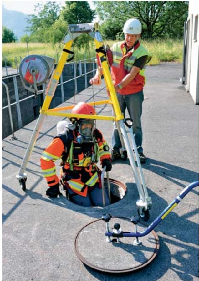
**Figura 20** Discesa in un pozzo tramite una scaletta. L'operaio è assicurato con un'imbracatura e un dispositivo anticaduta provvisto di manovella di salvataggio che permette di sollevarlo dall'esterno in qualsiasi momento.
