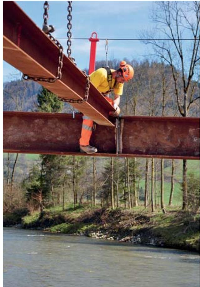
**Figura 25** Montaggio di una struttura in acciaio con dispositivo di sicurezza su linea vita orizzontale.
